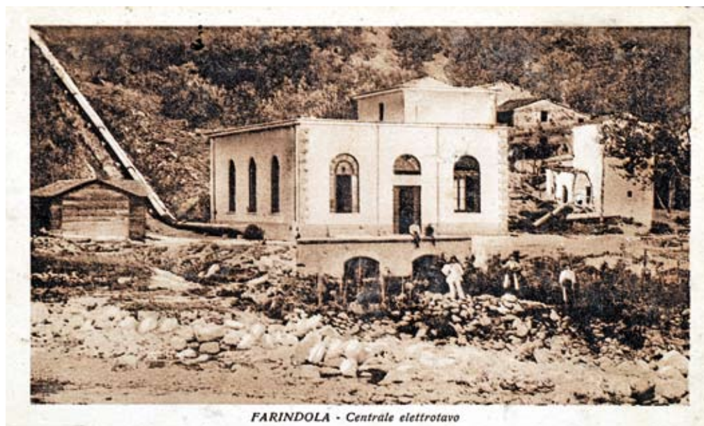
FARINDOLA - Centrale elettrolavo
